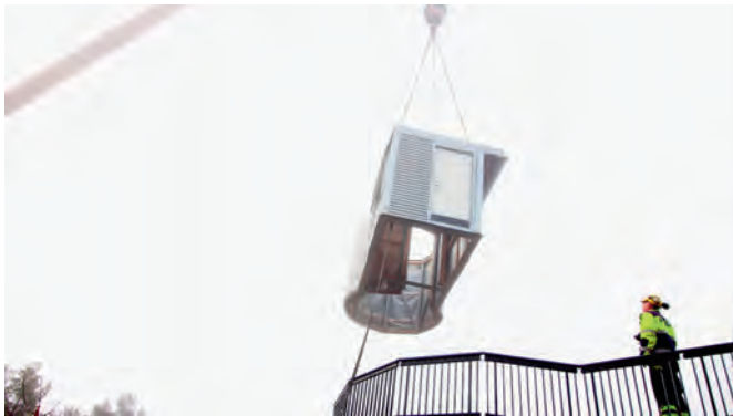
Her ankommer underbygget (observatoriets kontrollrom). NN fra Nordic Crane er klar til å ta imot kontrollrommet.
