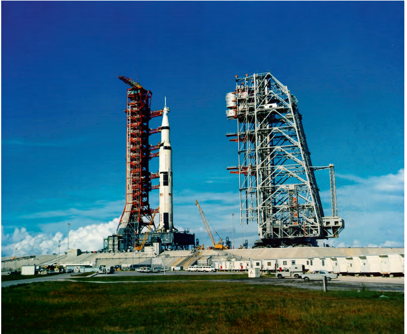
Det store transportkjøretøyet er vel fremme ved oppskytningsplattformen etter en heldagstur fra VAB. Legg merke til servicestrukturen til høyre, FSS (Fixed Service Structure), som gjør det mulig for personell å jobbe langs rakettkroppen. FOTO: NASA fra ALSJ skannet av Kipp Teague.
